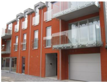
Nouvelle structure RS
