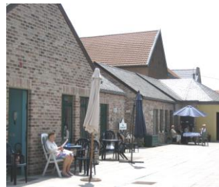
Bungalows en Résidence - services
